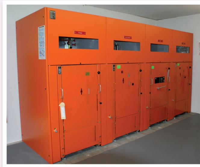
*Klassisches 16 kV Schaltfeld mit Ölstrahlschaltern in der Transformatorstation Käseerei*
