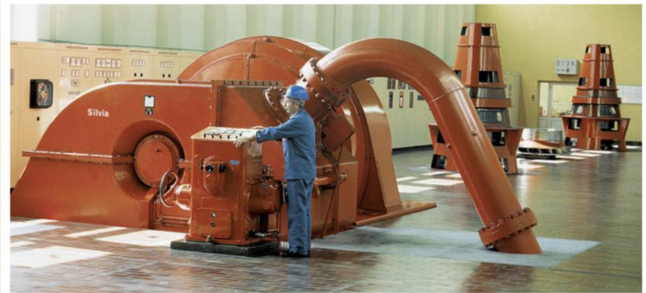
Maschinensaal der Zentrale Löntsch mit zwei Francis- und einer Pelton-Turbine nach der Erneuerung 1971-75
